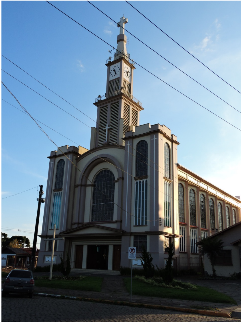
Fotografia 2 – Prédio da Igreja Matriz de São Francisco de Paula
