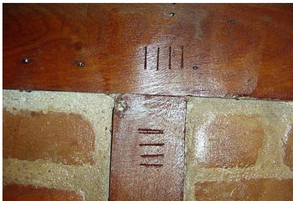
F2. Peças com numeração, para definir os locais de encaixe. Fonte: foto do autor.
