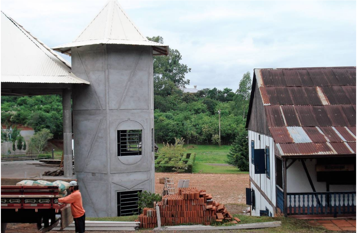
F7. “Torre” em falso enxaimel, antes de receber a pintura sobre as faixas, que são rebaixos no reboco. Observe-se a janela basculante metálica, que por si só já denunciaria não se tratar obra autêntica. Ao lado direito, casa em enxaimel verdadeira. Fonte: foto do autor.
