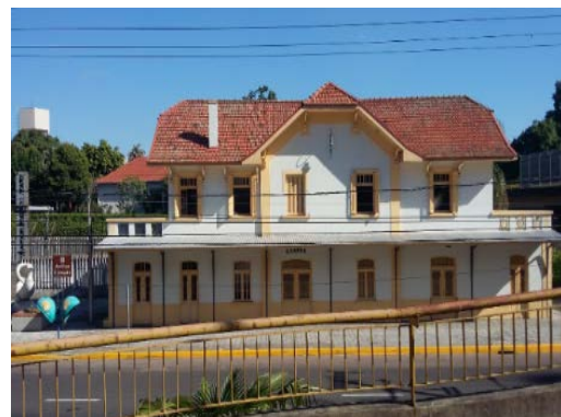
Figura 6 – Antiga Estação de Trem
