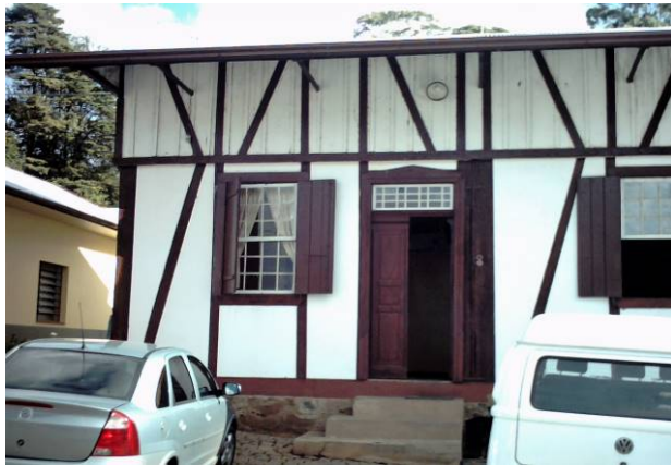
F12. Prédio em enxaimel teve seu telhado trocado e ampliado. Fonte: foto do autor.
