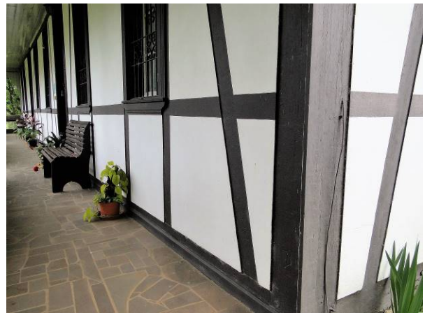
F11. A falsa faixa horizontal segue, contornando todo prédio. Fonte: foto do autor.
