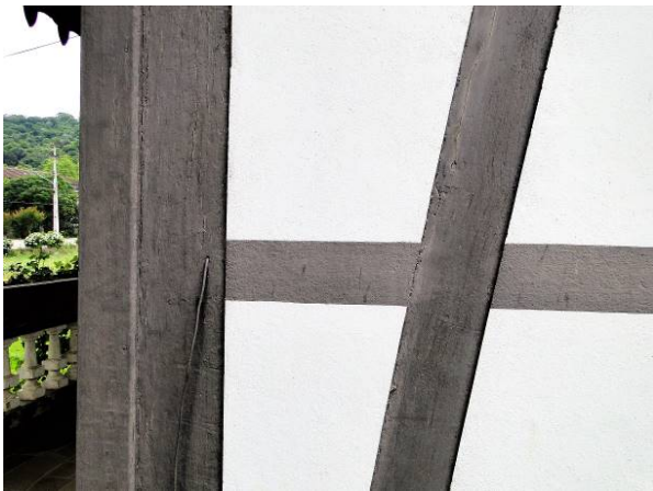
F10. A faixa horizontal não é de madeira, é pintura sobre o reboco. Fonte: foto do autor.
