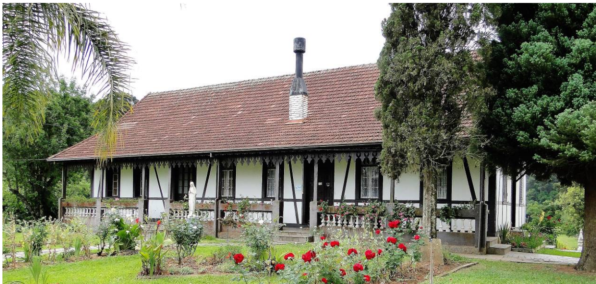
F9. Veja-se que belo exemplar de casa construída com a técnica de enxaimel. Fonte: foto do autor.
